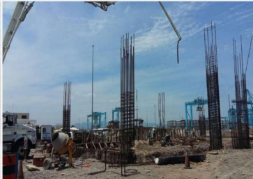
Excavación, habilitado y construcción de zapatas, dados, dalas de desplante, y columnas, para el edificio administrativo del M&R.
