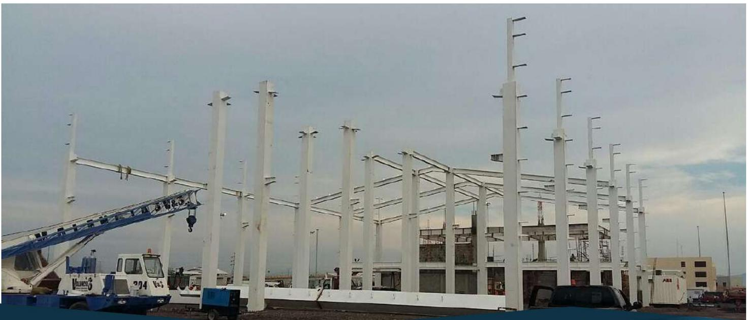
Habilitado de columnas y traveses metálicas en área de taller de mantenimiento.
