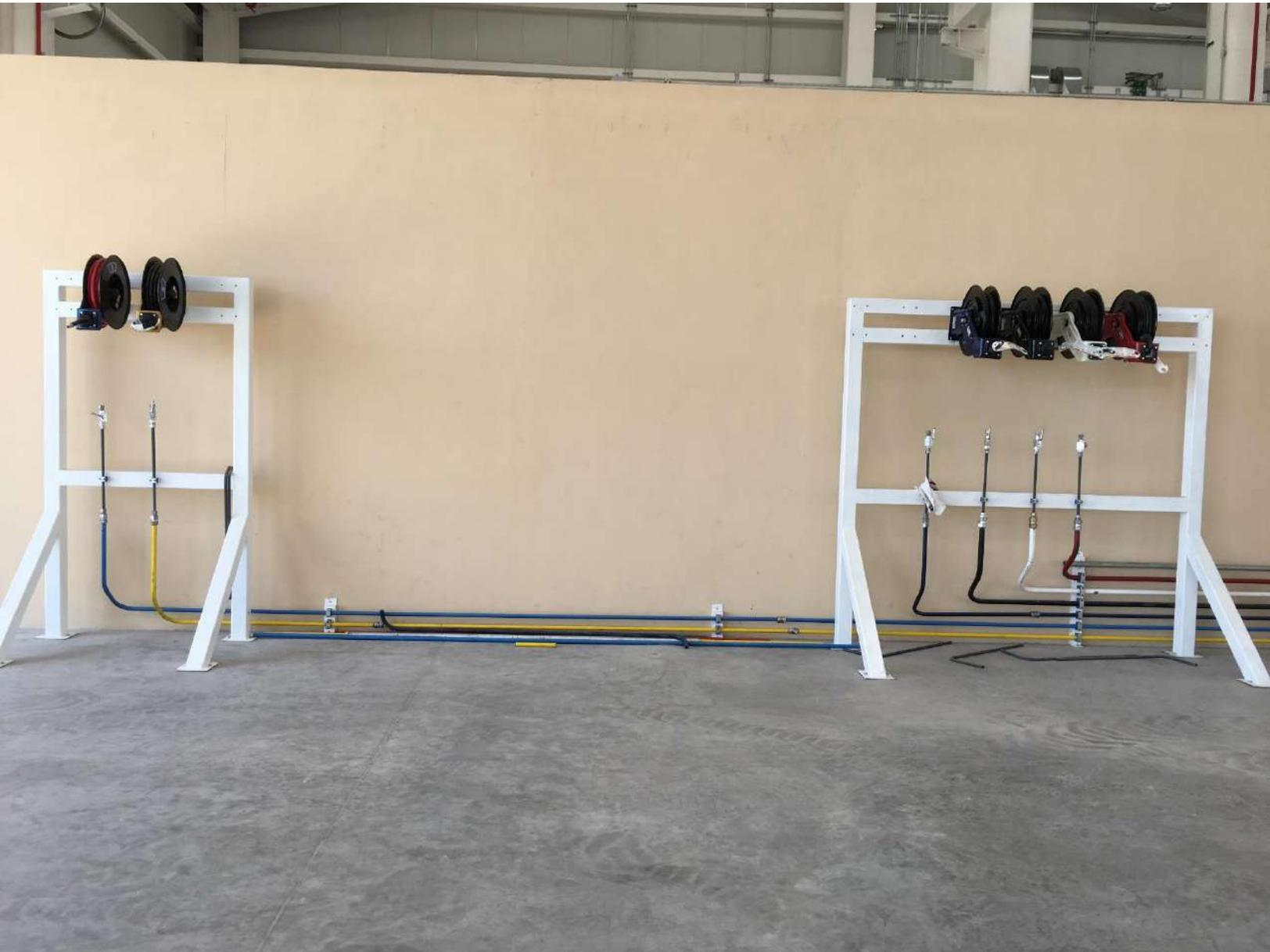
Se instalaron equipos especializados para despachar líquidos lubricantes, al igual que se realizó la instalación de la tubería correspondiente, del cuarto de maquinas asignado hasta los despachadores. El cual fue colocado de manera funcional para evitar algún accidente.
