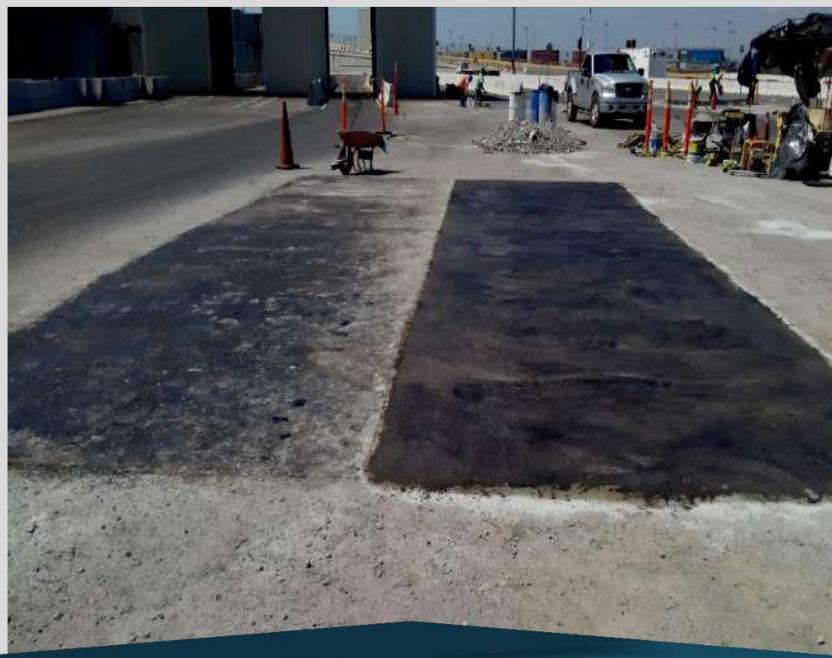
Reparación de tubería subterránea dañada de agua en Terminal de Contenedores Especializada APM TERMINALS Lázaro Cárdenas, Michoacán.
