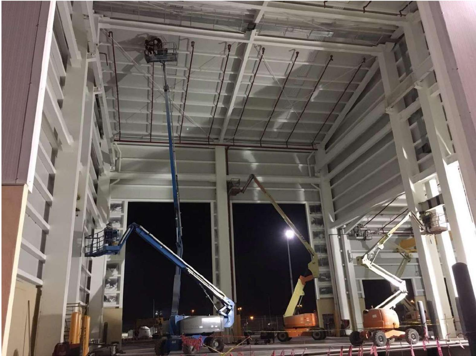
Se realizaron instalaciones de tuberías contra incendios en el taller y en el interior del edificio de oficinas.
