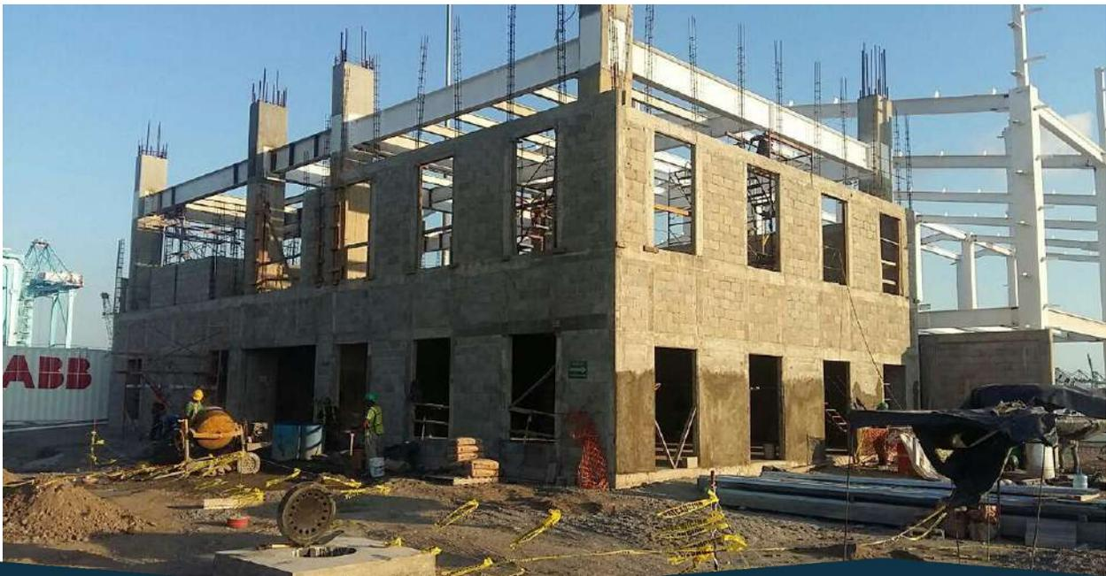
Construcción y habilitado de columnas, muros de block, preparación de columnas para conexión de traveses metálicas primarias y secundarias para habilitar losacero. Edificio administrativo del M&R.
