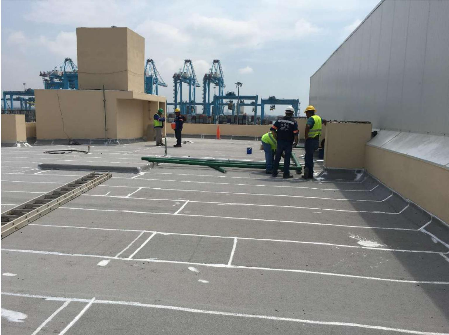
Colocación de impermeabilizante asfáltico en losa de edificio administrativo M&R.
