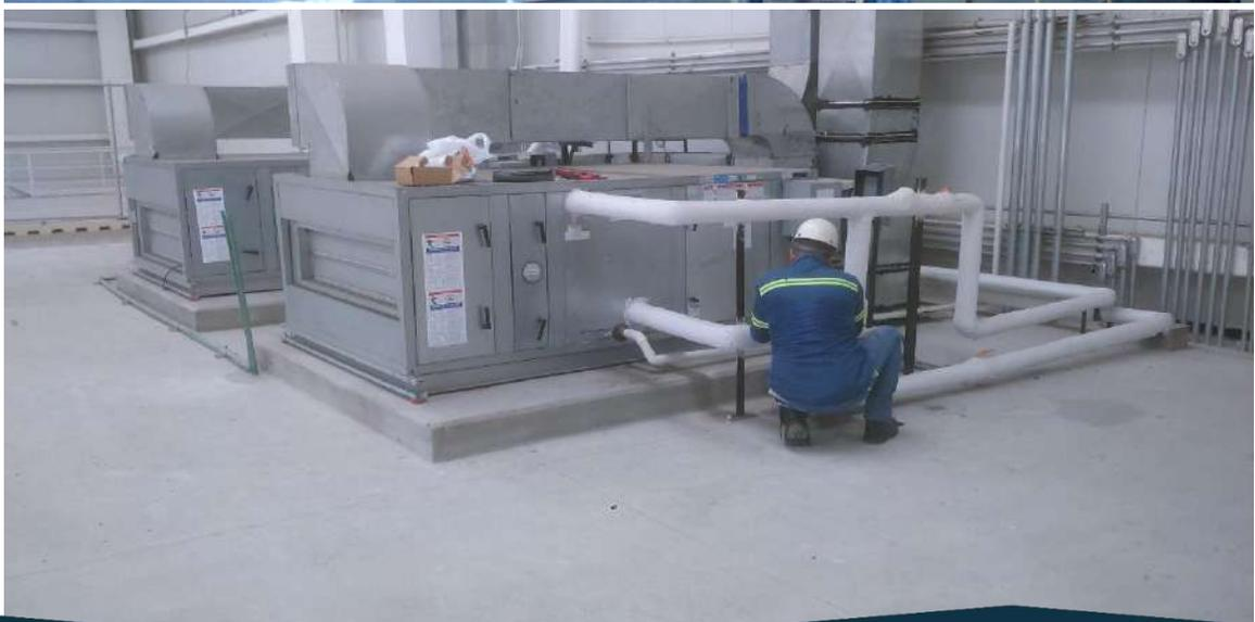
Se realizaron instalaciones de equipos y ductos de aire acondicionado.
