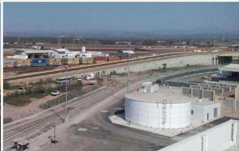
Construcción de tanque de agua para contra incendios de capacidad de 1,000,000 Litros, tiene dimensiones de 18.5 m de diámetro y 7.05 m de altura, elaborado con acero al carbón.
