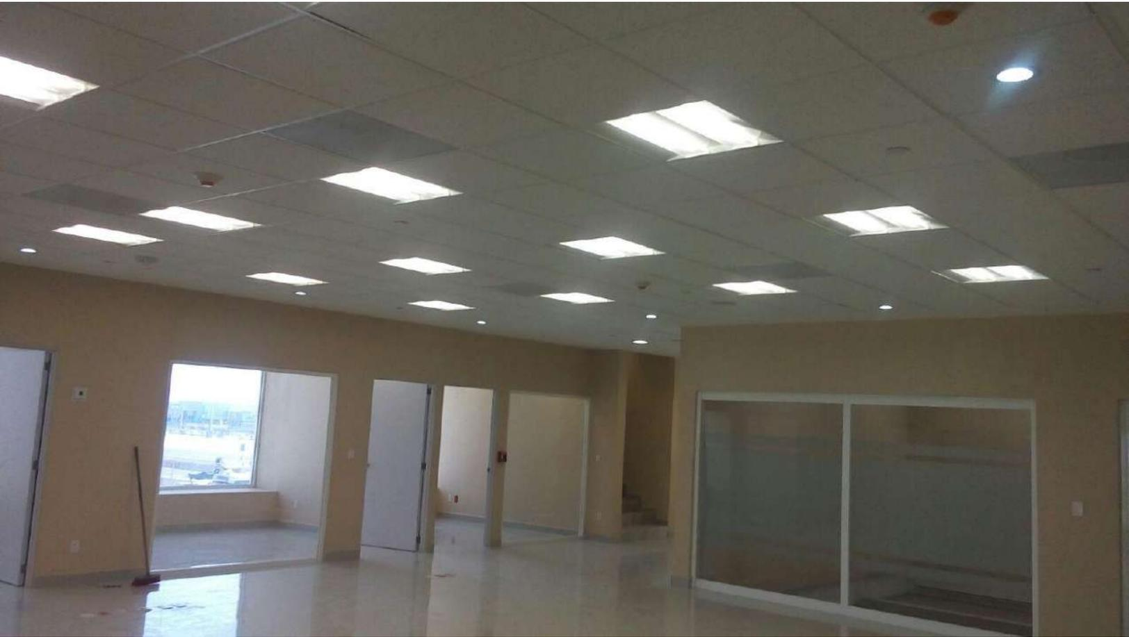
Se realizaron trabajos interiores, Instalación de muros y plafones de tablaroca, colocación de porcelanato rectificado, colocación de cancelería y cristal, colocación de puertas de madera forradas con formica blanca, aplicación de pintura y las instalaciones correspondientes (eléctricas, hidráulicas, aire acondicionado)
