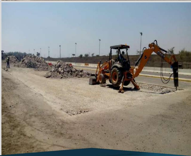
Reparación de pavimentos dañados por maquinaria.
