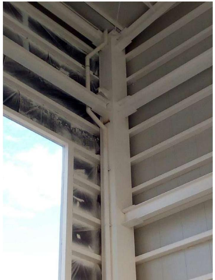
Se aplicó pintura anticorrosiva en las estructuras metálicas y una protección de fire control para retardar la expansión de fuego en ellas.
