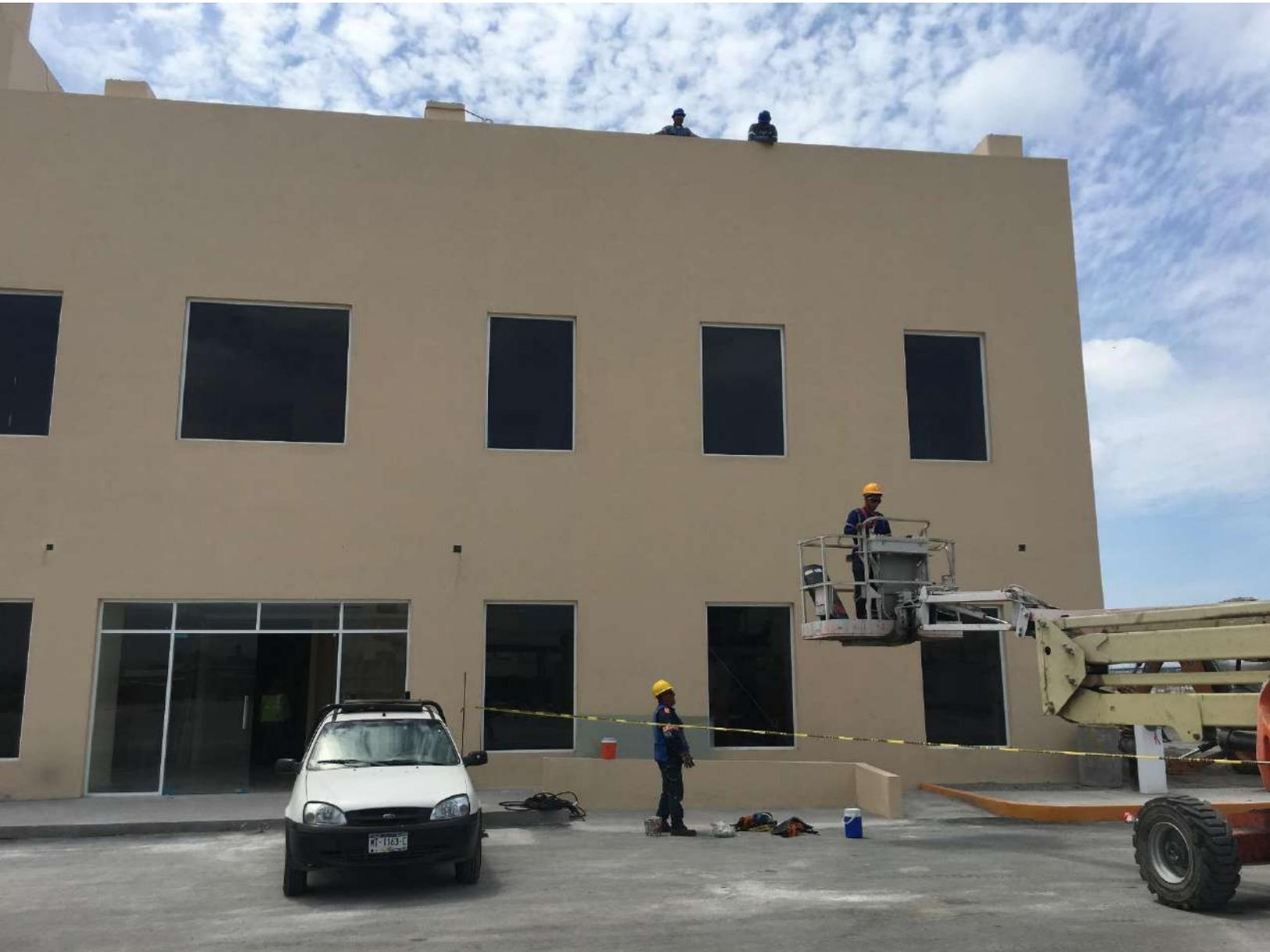
Colocación de cancelería fina con aluminio anodizado color blanco y doble cristalamiento térmico.
